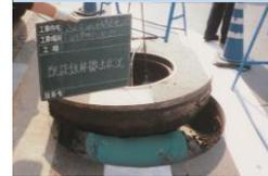
内部ジャッキを設置し、吊り上げ撤去
