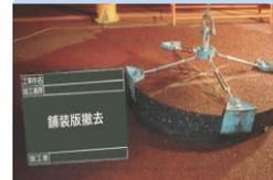
舗装版用吊具を設置し、吊り上げ撤去
